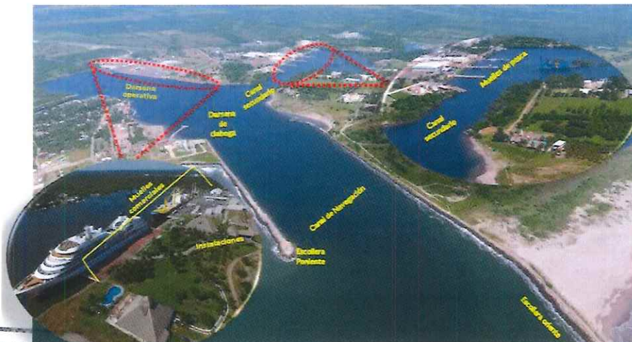
Infraestructura portuaria de Puerto Chiapas
